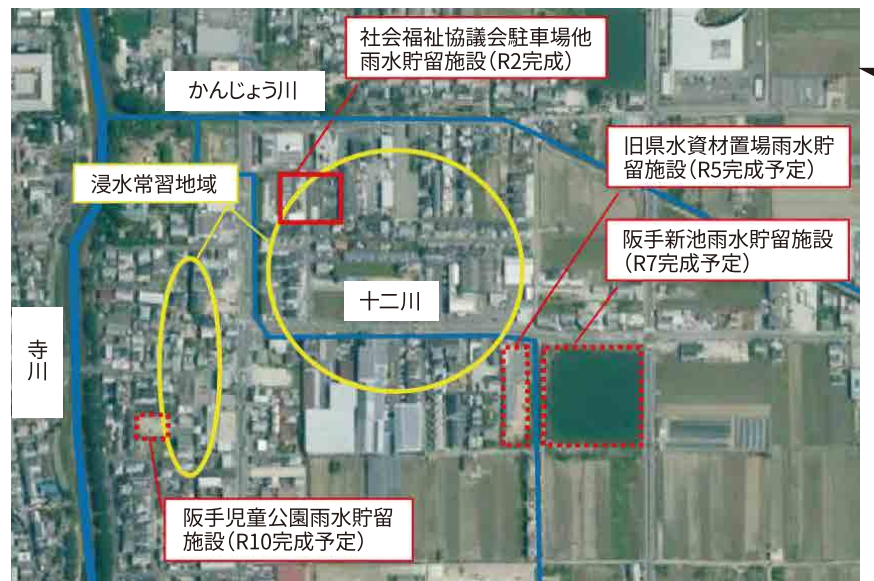
阪手地区の雨水貯留施設の整備状況
